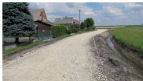
Na zdjęciu: Ulica Krzywa w trakcie robót ziemnych
