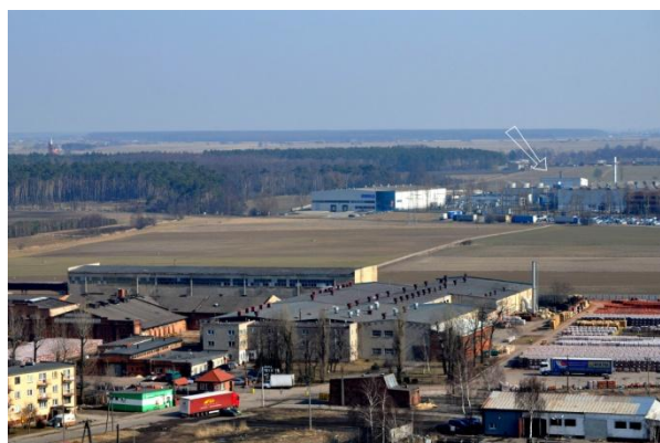
widok z elewatora (od zachodu)
