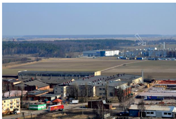
widok z elewatora (od zachodu)
