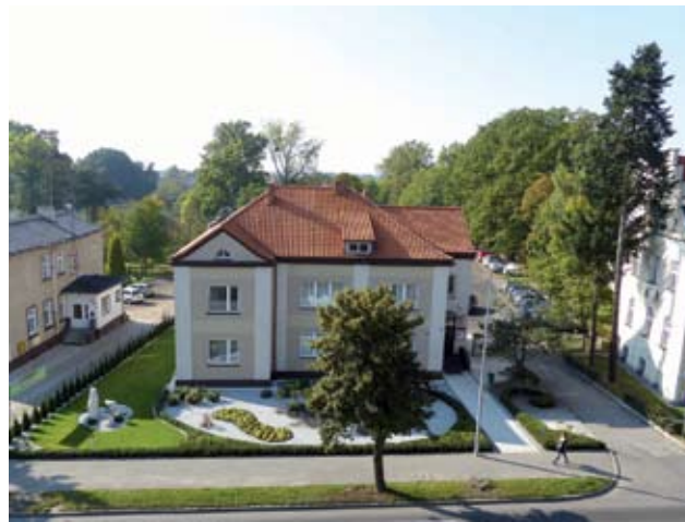
Drugi budynek UM przy ul. Kołłątaja po remoncie
