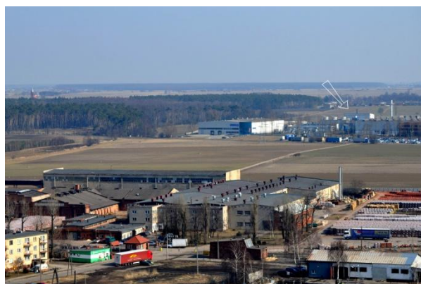
widok z elewatora (od zachodu)
