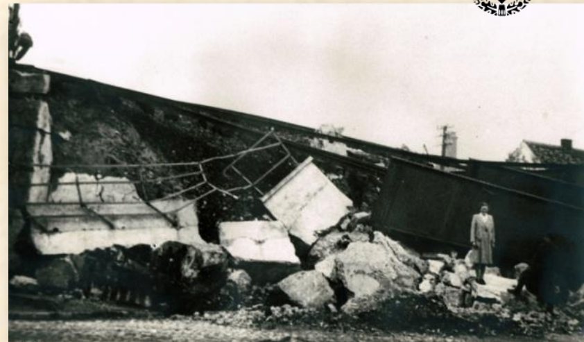
Zniszczony wiadukt przy ul. Konarzewskiej (?)
